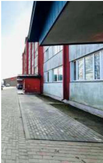
Daudzdzīvokļu dzīvojamās ēkas fasāde
