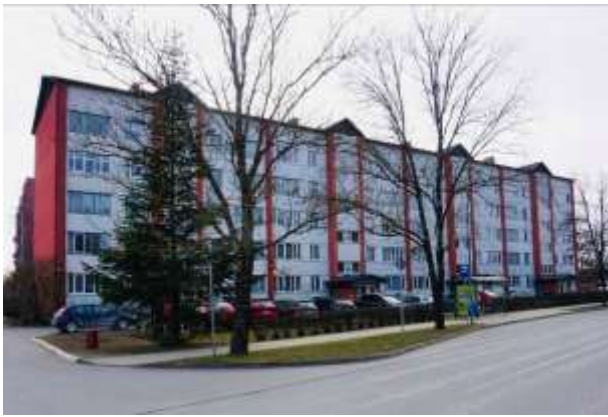
Daudzdzīvokļu dzīvojamās ēkas fasāde
