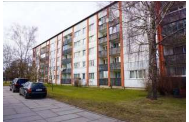
Daudzdzīvokļu dzīvojamās ēkas fasāde
